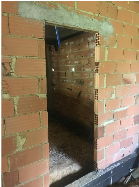
Foto 02 – Cozinha/Cantina Pavimento Térreo (Sem Instalações Hidrossanitárias)
